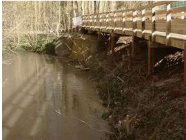
Comme on peut le voir sur cette image, la structure du platelage est faite de pieux. En effet, un plateage sur plot est invisible dans ce type de situation.
