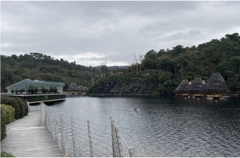
Fig. 31. Vu du lac asséché à Trégnanton, écluse et maison éclusière, lac de Guerlédan, 2015 ©Titval
